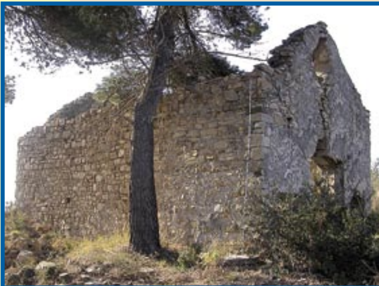
Prospetto nord: muratura in pietra
