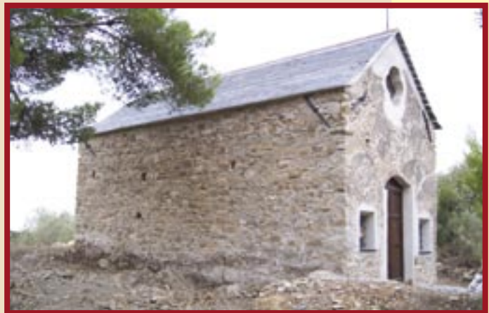
Chiesetta di San Bernardo ristrutturata
